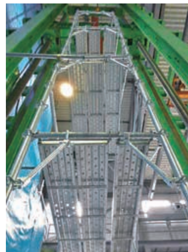
支柱強化の荷重試験
