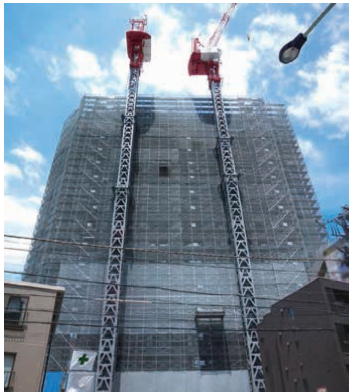
高さ80メートル超のタワーマンション 強化方づえ使用 B2階からの立ち上がりの足場部分は最高高さ約90メートル
