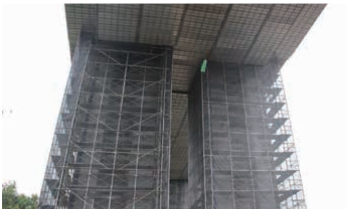
高速道路橋脚 上部工の吊り足場SKパネルと組み合わせて設置
