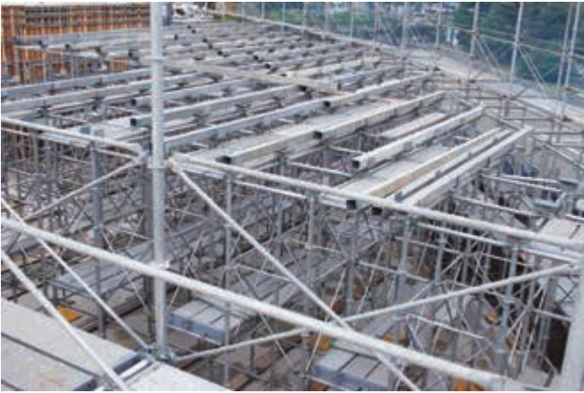
アルバトロスの支保工。くさび式の専用システム支保工と同様にX・Y方向に自由なピッチで割り付け可能。 さらに支保工も安全な手すり先行工法で組立・解体が可能。
