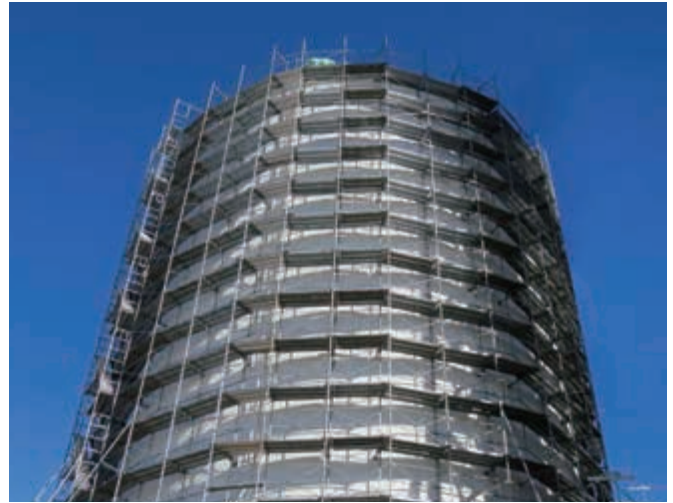
LNGタンクに設置したアルバトロスの円形足場。専用の円形足場用先行手すり、伸縮手すりをを用いることによって全て手すり先行工法で組立解体が可能。
