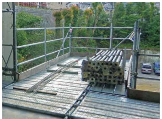
梁枠併用で広い開口確保
