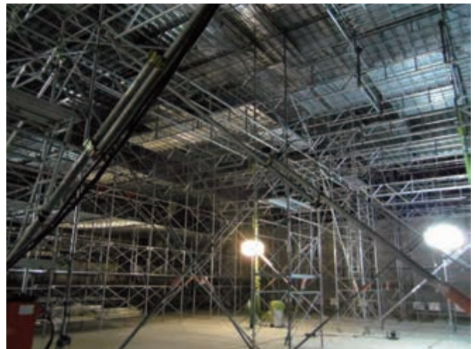
養生用の仮天井の上部状況。上側の天井作業用ステージまでの空間も広々。
