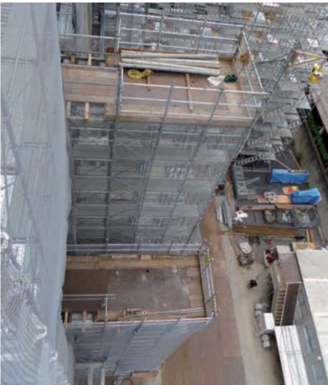
物流倉庫工事にてスラブにレベルを合せて設置したフォークリフト用の荷取り構台。敷鉄板敷設。 大引受ジャッキを使用して外周に手すりを簡単に設置することが可能。
