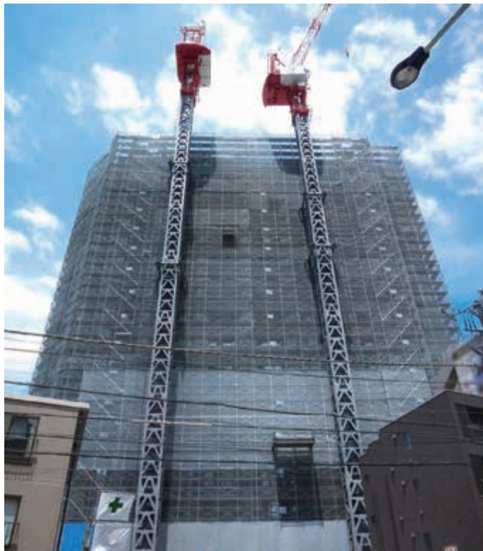
高さ80メートル超のタワーマンション 強化方づえ使用 B2階からの立ち上がりの足場部分は最高高さ約90メートル
