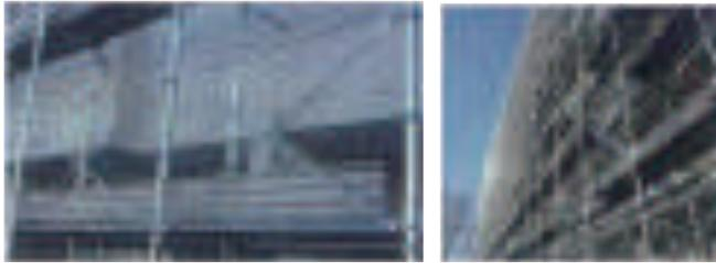
○ 先行手摺ブレスは斜材の機能を有しているため、大ブレスは必要ない。
