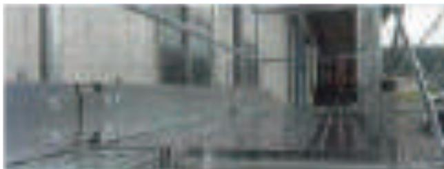
○ 枠組足場と同じ床付き布枠が使用可能。高所での作業も下が見えないので安心。床材の許容荷重250kgfで安心。
