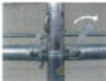
○ 布材撤去時に片側づつくさびを保持する事ができ、作業しやすい。
