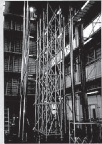
積載荷重は支柱1本当たり、以下の許容荷重の値以下とする。
