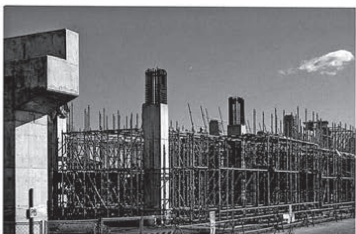
■北陸新幹線現場
