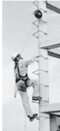
安全ブロックはリトラクタ式墜落阻止器具とい、作業者が高所から落下するのを防止するためのものです。写真のようにフックを安全帯に引掛けて使用します。フックを引張るとキーバー本体からワイヤロープを引き出すことができますが、素早く引出す(使用者が落下すると)ブレーキが動作します。また、ワイヤロープの自動巻取り(リトラクタ)機能を備えているため、ワイヤロープは常にピンと張った状態になります。
